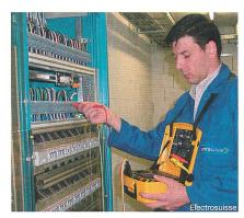
Figure 1 Contrôle final selon les normes sur les installations à basse tension
