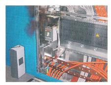
Figure 3 Disjoncteur démonté sous tension
