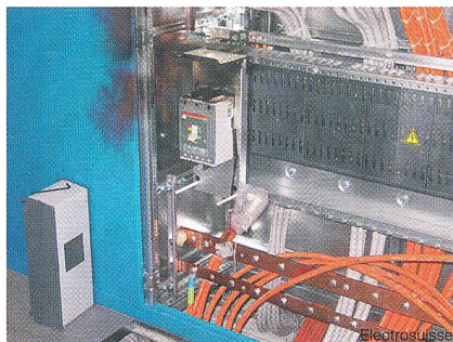
Figure 3 Disjoncteur démonté sous tension
