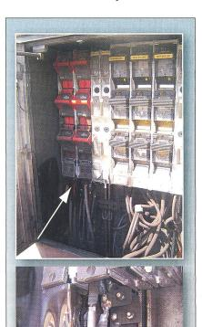
Figure 1 Le monteur a provoqué un court-circuit dans cette armoire de distribution avec les pointes d'essai d'un contrôleur du champ tournant
