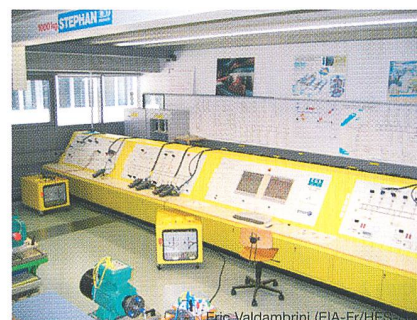
Figura 1 Simulatore della rete elettrica di Friburgo Rete 220/60 kV riportata a 3×400 V
