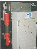
Bild 6 Umbau eines Schalters Schalter mit Primärschutz (a) und umgebaut mit Sekundärschutz (b)
