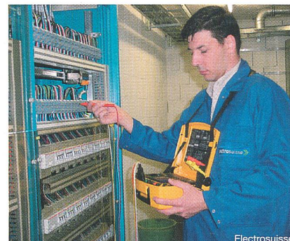
Bild 1 Schlusskontrolle nach der Niederspannungsinstallationsnorm
