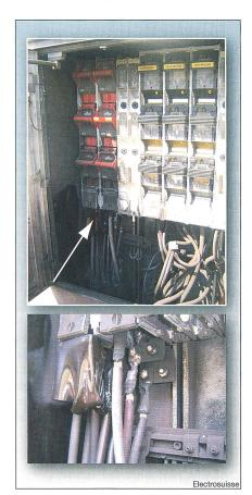
Bild 1 Mit den Prüfspitzen eines Drehfeldprüfers löste der Monteur in dieser Verteilkabine einen Kurzschluss aus
