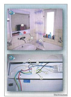
Bild 4 Spiegelschrank falsch verdrahtet
