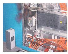
Bild 3 Leistungsschalter unter Spannung demontiert
