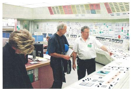
Die jährlichen Abstellungen in der Beznau werden von Medienvertretern regelmässig genutzt, um sich ein Bild von den aktuellen Modernisierungen zu machen; hier hinteressiert die Erneuerung der Turbinen-Leittechnik und deren Instrumentierung im Kommandoraum (Bild: nok).
