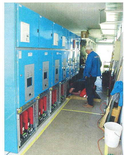
Inbetriebsetzung der Schaltanlage.
