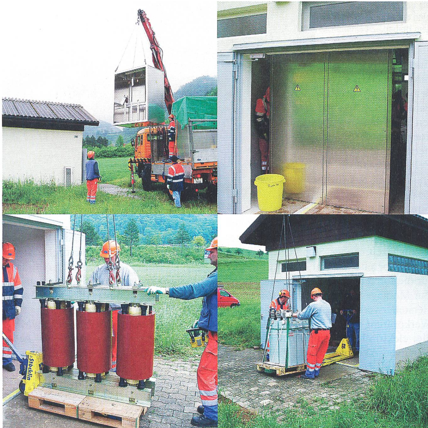
Montage der Kompensationsanlage.
