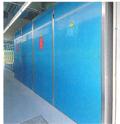
Die zwei Doppelzellen der Rectiphase-Kompensationsanlage.
