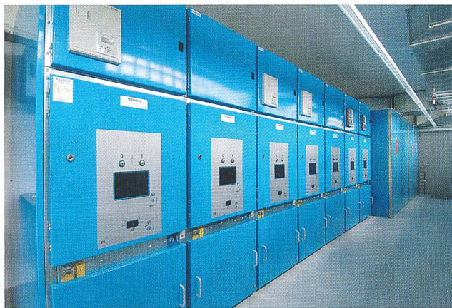
Die PIX-C-Mittelspannungs-Schaltanlage.
