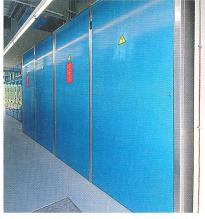
Die zwei Doppelzellen der Rectiphase-Kompensationsanlage.
