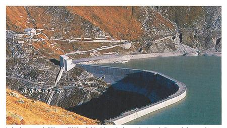
Le lac de retenue de l'Oberaar (2300 m d'altitude) sert également de réservoir d'accumulation pour le pompage-turbinage (photo KWO).
