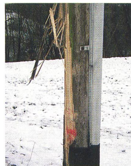
Beschädigte Stangen werden rot markiert (Bilder: ebl).
