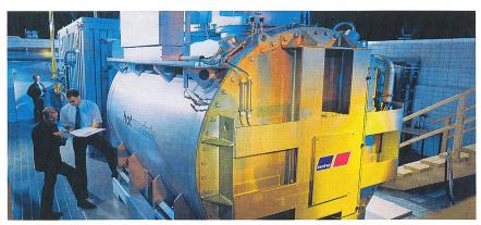
HotModule (mit bis zu 245 kW<sub>el</sub> und 170 kW<sub>th</sub>) von MTU CFC Solutions.
