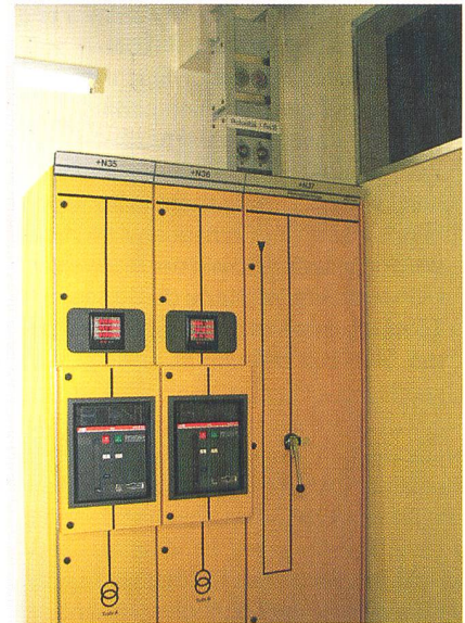
Hier wird die Energie der Fotovoltaikanlage via EWB ins Netz der BKW eingespeisen
