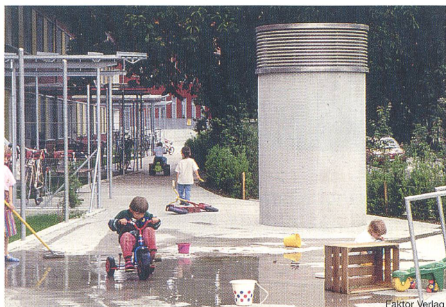
Bild 3 Beispiel für eine Aussenluft-Ansaugöffnung
