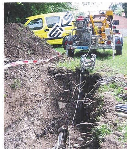
Eine der zahlreichen freigelegten Stellen, an der sich die Kabeltrasse abgesenkt hat (Bild: eks).
