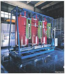
Bild 6 Das Bauprinzip ist physikalisch bedingt ähnlich wie bei anderen Transformatoren, jedoch sind die Unter- und Oberspannungswicklungen giessharzisoliert
