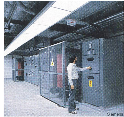
Bild 1 Verteiltransformatoren werden immer näher am Verbraucher installiert. Dies stellt hohe Anforderungen an die Sicherheit, wobei dem Brandschutz hohe Bedeutung zukommt.
