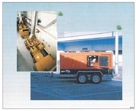
**Bild 3 Notstrom-Dieselaggregate können fest installiert oder mobil sein**Bild a: fest installiertes Notstrom-Dieselaggregat; Bild b: mobiles Notstrom-Dieselaggregat
