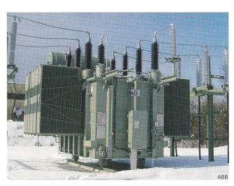
Bild 5 Querregeltransformator 100 MVA, 110 kV/110 kV
