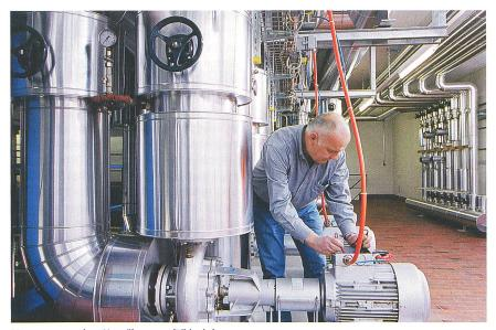
Messungen an einer Umwälzpumpe (Bild: ekz).
