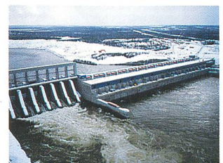
Construction de Bouygues: Barrage de la Baie James/Canada.
