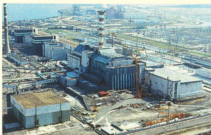
Reaktorblock IV des Kernkraftwerks Tschernobyl, eingehüllt im «Sarkophag».
