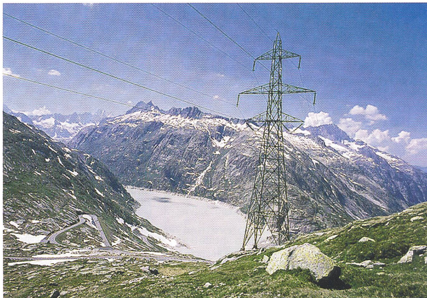
Stromleitung über die Grimsel: Auch die höchsten Hürden werden überwunden (Bild: vpe).
