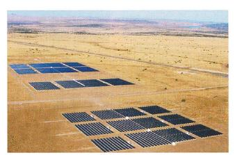
Grösste PV-Anlage der USA: Springerville in der Wüste bei Tucson, Arizona (35 000 Module/4,6 MW<sub>p</sub>).
