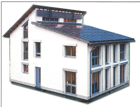
PV-Energiedach (Bild SolarWorld).
