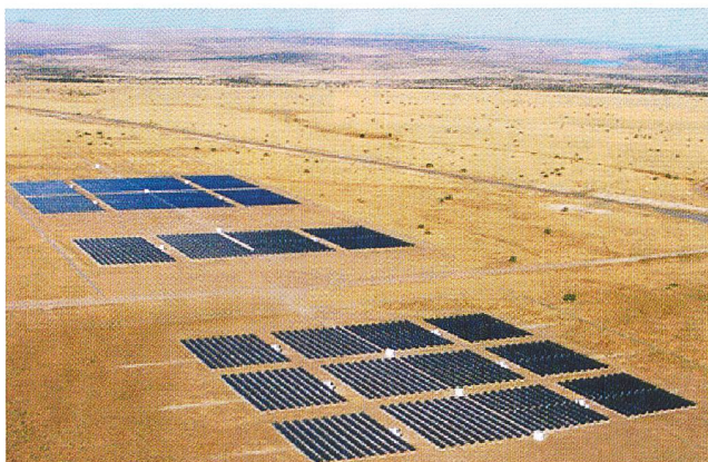
Grösste PV-Anlage der USA: Springerville in der Wüste bei Tucson, Arizona (35 000 Module/4,6 MW p ).
