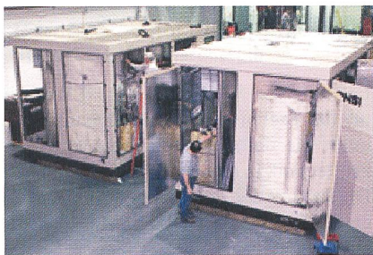
Die United Technology-ONSI-200-kW-Anlage in der Polizeistation im Central Park von New York hat bereits über 60 000 Stunden mit dem ersten Stapel.
