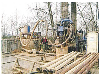
Horchbohrungen bei Basel.
