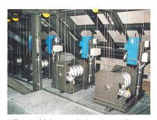
Selbst entwickelte Prospektzüge mit geregelten Gleichstromantrieben, Doppelbremsen und Lastmessungen, hergestellt nach den gültigen europäischen Richtlinien BGV C1
