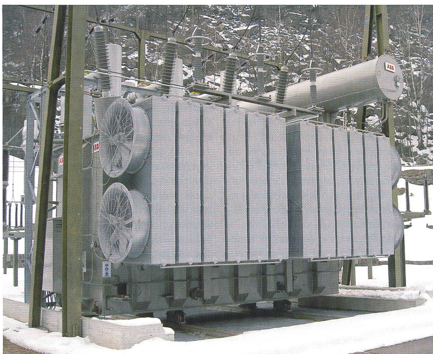
Figure 1 Transformateur AET-250MVA de la Centrale Piottino (Tessin)
