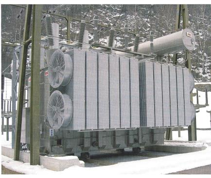
Figure 1 Transformateur AET-250MVA de la Centrale Piottino (Tessin)
