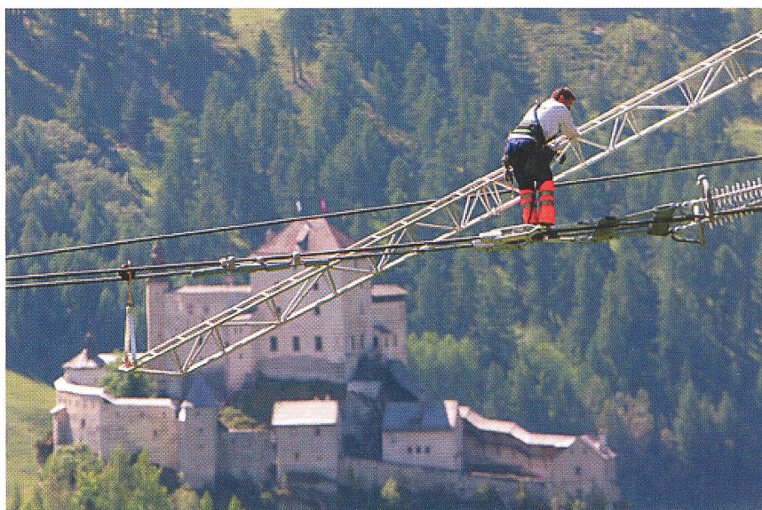
Montagearbeiten für die Spezialtragketten bei Ftan in luftiger Höhe mit Schloss und Dorf Tarasp im Hintergrund auf der gegenüberliegenden Talseite (Bild: ekw).
