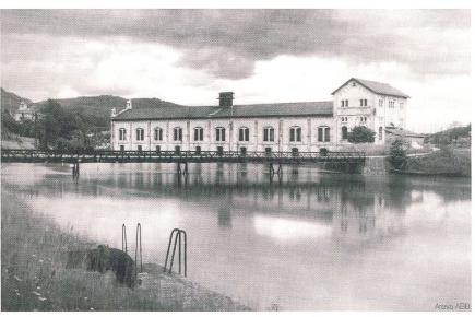
Baukunst aus den Pioniertagen des Kraftwerkbaus: Das Kraftwerk Ruppoldingen oberhalb von Aarburg im Kanton Solothurn wurde 1896 gebaut und verfügte über eine Leistung von 2500 PS. 1925 wurde es erstmals umgebaut und mit neuen Maschinen von gesamt 7000 PS ausgerüstet. Im Jahr 2000 wurde das alte Gebäude durch einen Neubau ersetzt. Das Kraftwerk produziert heute mit einer installierten Leistung von 23 MW (rund 31 000 PS) durchschnittlich 115 Mio. kWh pro Jahr.
