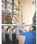
Prototyp der Reinigungsanlage für spannungsführende Anlagen.
