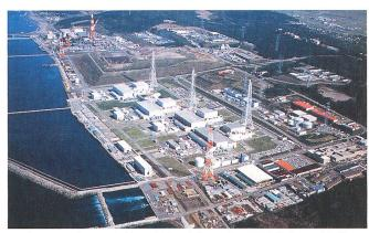
Druckwasserreaktoren Kashiwazaki-6 und -7 vom Typ ABWR (Advanced Boiling Water Reactor, hinten) in Japan. Sie wurden innerhalb vier Jahren gebaut und sind kleiner als die bisherigen Anlagen.
