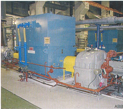
Bild 3 Antriebssystem mit Pumpe
