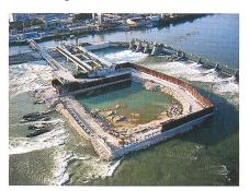
Baugrubenumschliessung der zweiten Baugrube wurde im November 2005 abgeschlossen. Die Baugrubenumschliessung sowie die neue Rampe für die zweite Baugrube sind fertig gestellt. Nach Abschluss der Injektionsarbeiten konnte mit dem Ausbruch des Muschelkalkfelsens noch im Dezember begonnen werden. Danach kann die Bodenplatte für die nächsten drei Wehröffnungen vorbereitet werden (Bilder: energiedienst).
