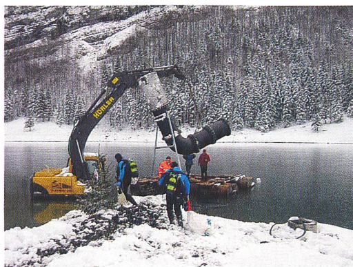
Installation der neuen Druckleitung am Seelapsee (Appenzell) November 2004 (Bild Iteco).
