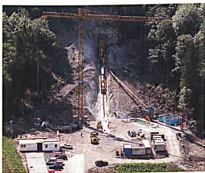
Baustelle in Oberrickenbach (Bild: Murer AG).
