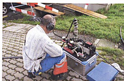
Ein Mitarbeiter der EKT AG überwacht das Einblasen des Glasfaserkabel (Bild: ekt).
