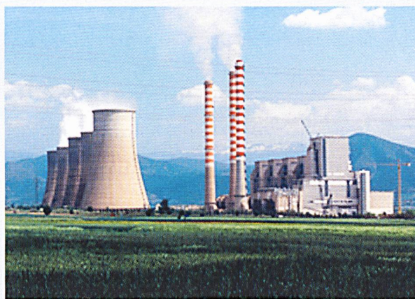
Kohlekraftwerk Agios Dimitrios (Griechenland; Bild Demotiki Epiheirisi Ilektrismou).
