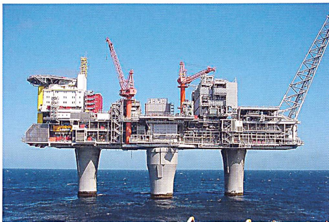
Die imposante 475 Meter hohe, über vier Stelzen mit dem Meeresboden verbundene Gasplattform Troll A.
