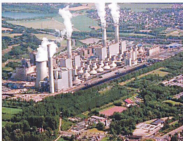
Braunkohlekraftwerk Frimmersdorf (Deutschland; Bild Digolo).
