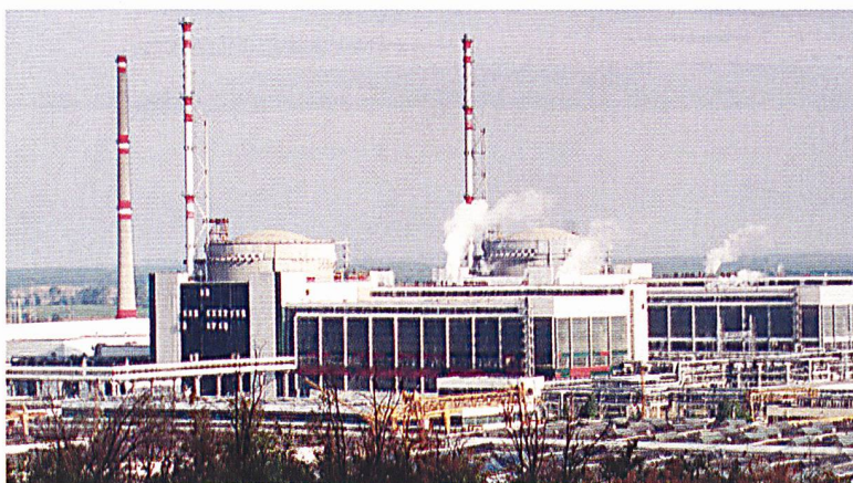
Die Energieintegration soll einen politischen Rahmen für die Förderung von Infrastrukturen im südosteuropäischen Elektrizitätssektor in der Höhe von 30 Mrd. US$ bringen (Kernkraftwerk Kozloduy; Bulgarien).
