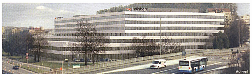
Die Business Area Balsberg Zürich Kloten – der frühere Hauptsitz der Swissair – wird schrittweise zu einem modernen Geschäftszentrum ausgebaut
