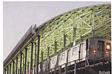
Station Stillwell Avenue (métro NY)
