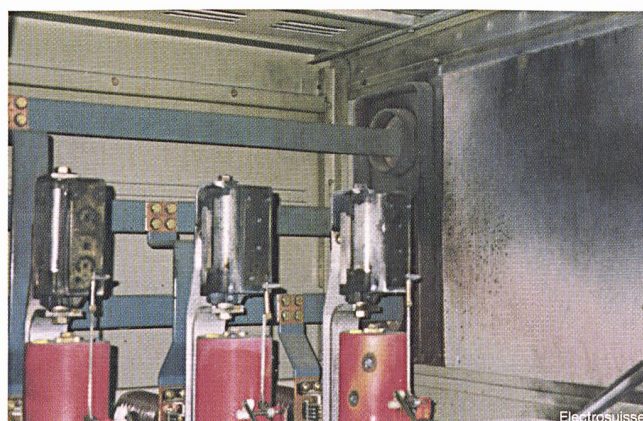
Fig. 15 Par mégarde, l'électricien de réseau voulait réarmer à la main l'organe de protection 16 kV sous tension
