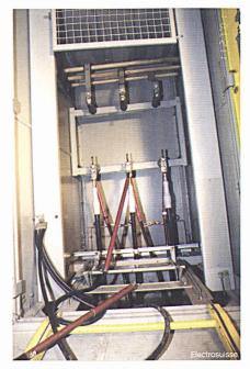
Fig. 11 Cellule avec garniture de mise à la terre et raccordement à la terre bloqué
