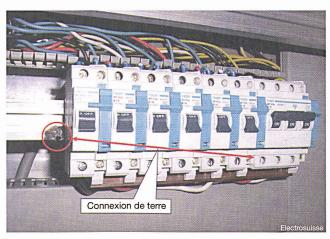
Fig. 6 Court-circuit à la terre entre la barre et la borne nue avant l'installation du nouveau disjoncteur de canalisation
