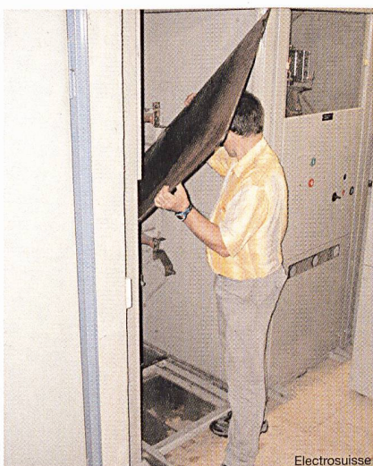
Fig. 8 La plaque est trop large et ne peut être introduite ... et où est l'équipement de protection individuelle? (situation simulée)
