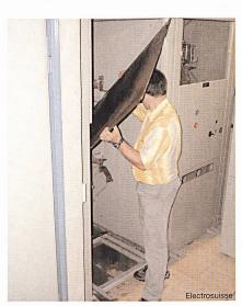
Fig. 8 La plaque est trop large et ne peut être introduite ... et où est l'équipement de protection individuelle? (situation simulée)
