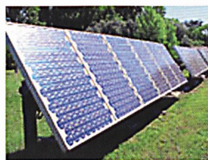
Solarmodule der Anlage in Moura (Portugal).
