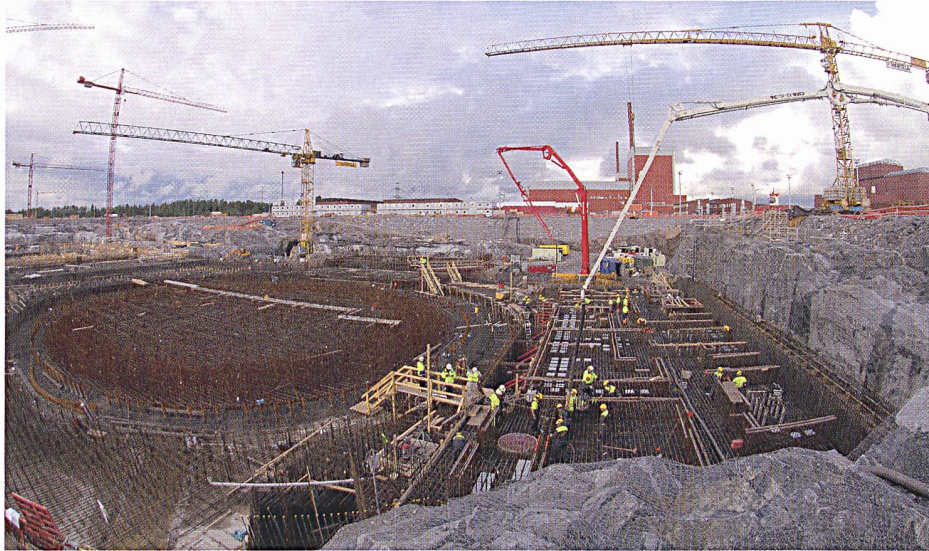
Baustelle des Druckwasserreaktors EPR in Olkiluoto (Finnland/Bild TVO).
