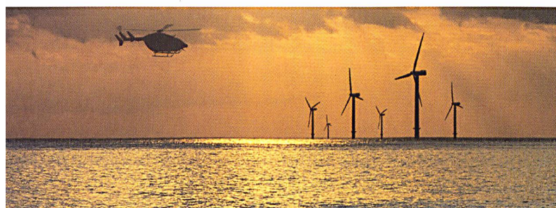
Offshore-Windkraftanlage (Bild Repower).
