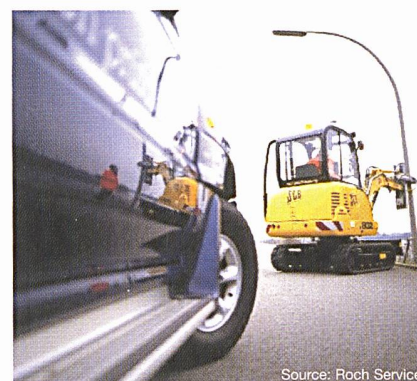
Figure 1 Le contrôle de la conformité mécanique des candélabres d'éclairage public
