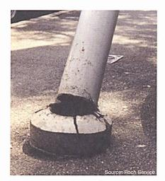
Figure 3 Fatigue et corrosion ont tendance à se développer dans les parties non visibles du fût
