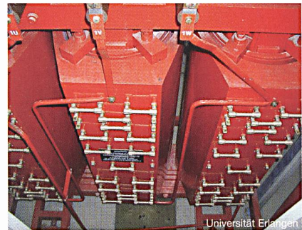
Bild 1 Oberspannungsseite des Hochstromtransformators
