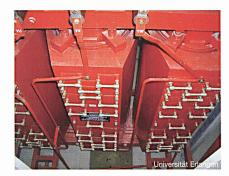
Bild 1 Oberspannungsseite des Hochstromtransformators
