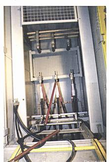
Bild 11 Schaltzelle mit Erdungsgarnitur mit festsitzendem Erdanschluss
