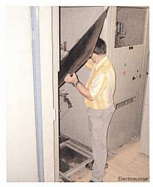
Bild 8 Die Einschubplatte ist zu breit und kann nicht eingeführt werden ... und wo ist die persönliche Schutzausrüstung? (nachgestelltes Bild)
