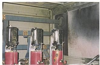
Bild 15 Der Netzelektriker wollte versehentlich von Hand den unter Spannung stehenden 16-kV-Hauptstrom-Überstromauslöser zurückstellen
