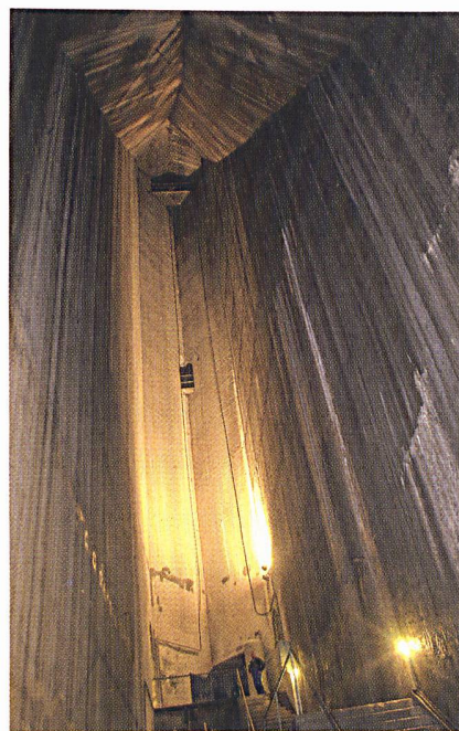
Die Besichtigung der Staumauer hinterlässt gigantische Eindrücke (Bild: ewz).
