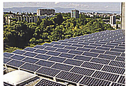
Effiziente Solarzellen in Genf (Bild: suntechnics).
