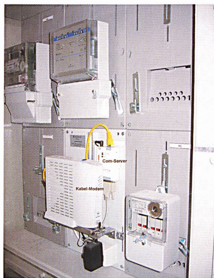
Kommunikationseinheiten (Comserver und Kabelmodem) sowie Lastgangzähler.
