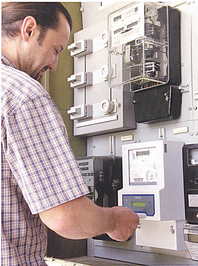
Bild 2 PMS-400 in der Praxis: Einsatz des PMS-400-Systems in der Messung eines Restaurants. Durch einfaches Stecken seiner Karte kann der Kunde jederzeit sein Restguthaben kontrollieren.
