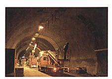
Vorbereitung der Brandtests mit Temperatursensorkabeln von Brugg Kabel AG
