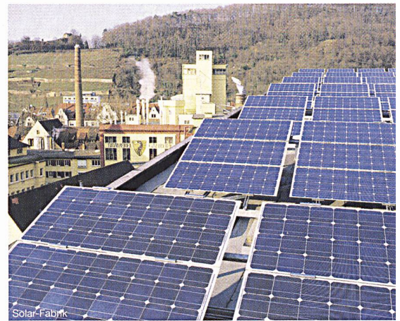
Cellules photovoltaïques de Solar-Fabrik pour la brasserie Ganter à Freiburg im Breisgau
