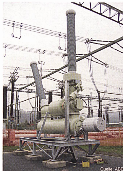
Bild 3 Neues 380-kV-Hybridschaltfeld
