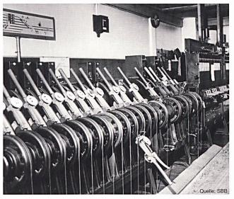
Bild 1 Mechanisches Stellwerk «Jüdel» (Thalwil Stellwerk I. in Betrieb 1922-1963)
