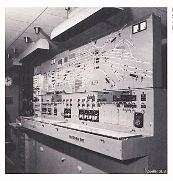
Bild 3 Elektromechanisches Stellwerk Burgdorf: «Schalterwerk Integra», in Betrieb seit Februar
