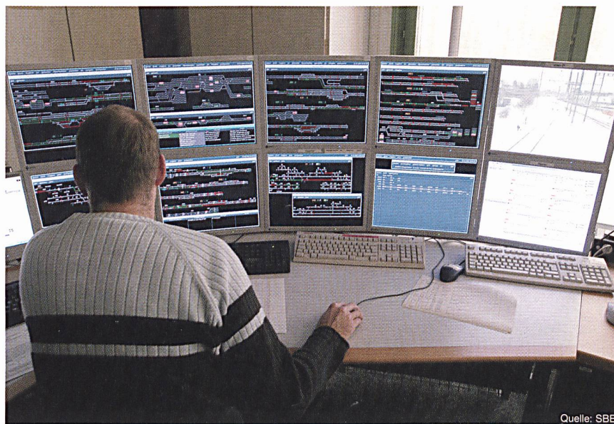
Bild 7 Fahrdienstleiter-Arbeitsplatz im Fernsteuerzentrum Olten (integrierte Leittechnik)
